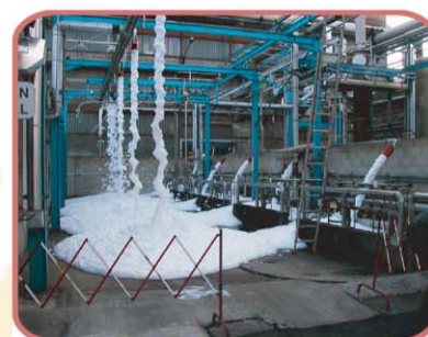
Dépotage parc de sulfure
