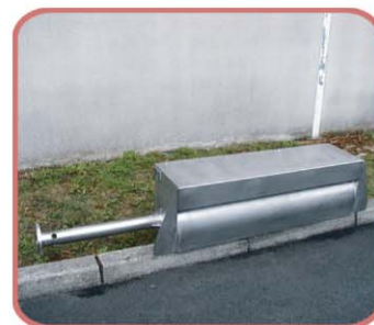
Générateur boîte à mousse pour protection des bacs de rétention
